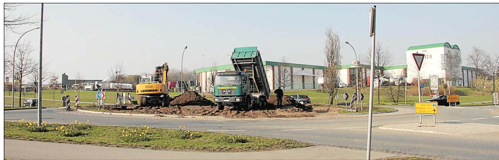
Beim Kreisverkehr an der Autobahn im Oelder Süden wird derzeit an der Optik gefeilt. Der schlechte Boden wird ersetzt durch besseren aus dem Jahnstadion. Darauf sollen Rasen und Blumenbeete wachsen. Bild: Hahn
